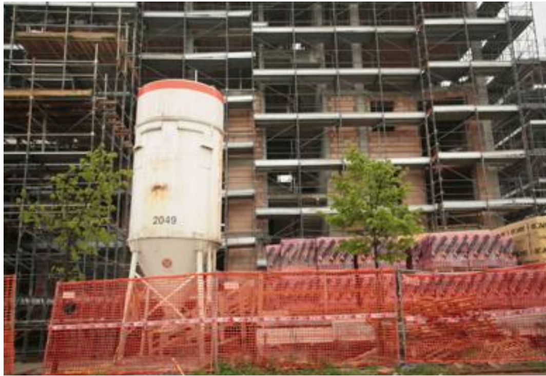
Il cantiere di via Leopardi dove si è verificato l'incidente: il muratore è precipitato procurandosi una ferita al capo
