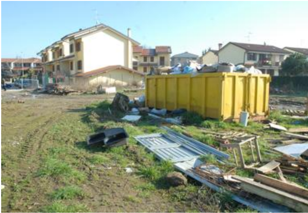
Il cantiere abbandonato alla fine di via Isola dove si trovano un contenitore pieno di rifiuti, sporcizia, assi di legno e tubi
