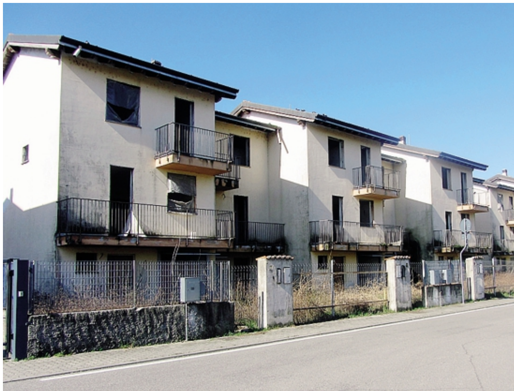
Le villette della Coop Garibaldina ferme dal 2004: un imprenditore sarebbe disposto a portare a termine i lavori
