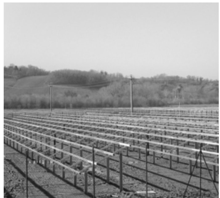
Uno scorcio dell'area di cascina San Bruno dove sta sorgendo il parco fotovoltaico
