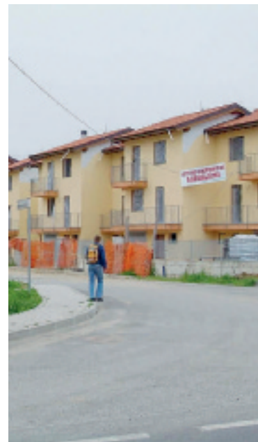
IN STALLO Gli acquirenti aspettano da anni di entrare in possesso delle proprietà pagate
