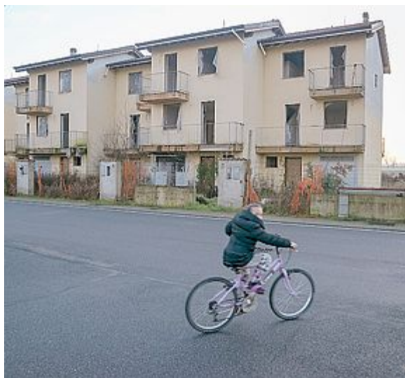
DEGRADO Le palazzine della coop fallita (Cavalleri)
